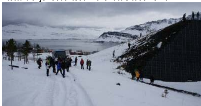
Við snjóflóðamannvirki í Neskaupsstað (© ljósmynd: Árni Jónsson)
